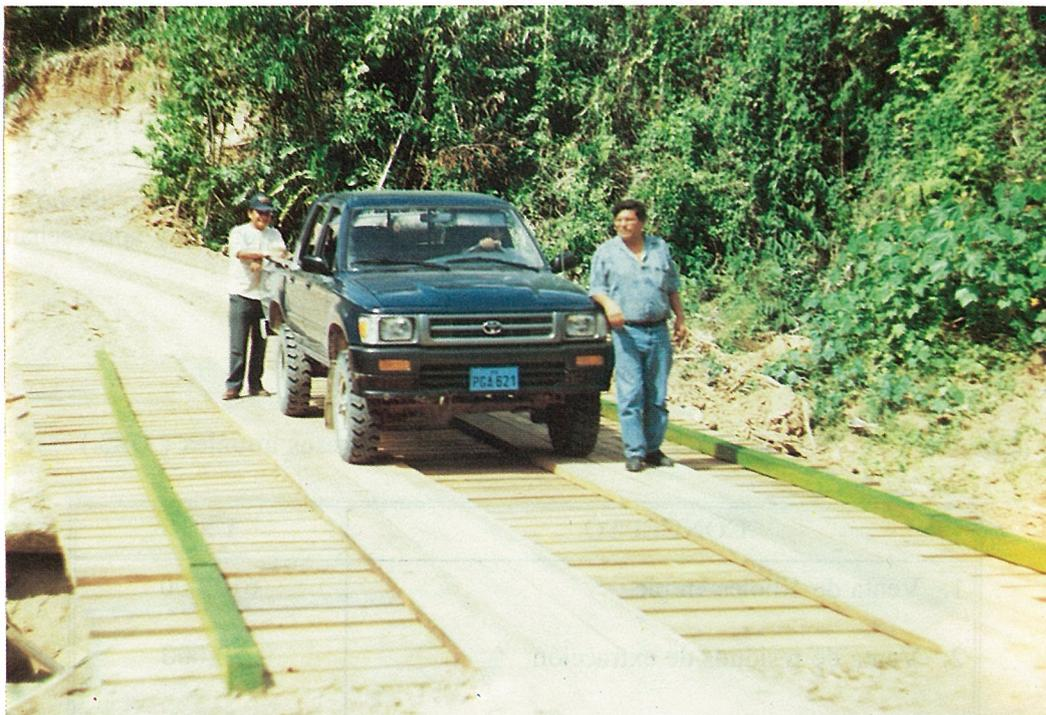
**FOTO 5** Puente construido con maderas duras de la región
